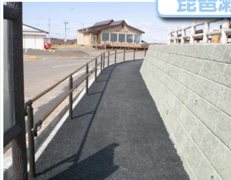
幅も広く傾斜も緩やかなスロープ、手すりも有ります
